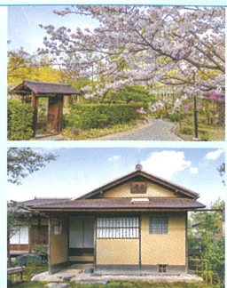
柿葺(こけらぶき)入母屋風の屋根が特徴の「如庵」。事前応募制の内部見学会も、定期的に開催。
